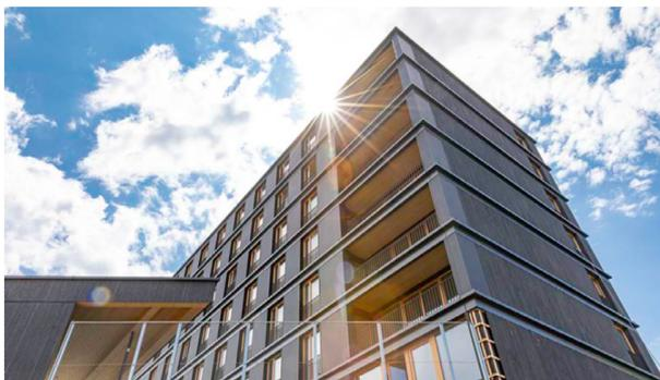
Preisträger des Deutschen Holzbaupreis 2023 – sieben Geschosse komplett in Holzbauweise ragen oberhalb des massiven Sockels von Buggi 52 in die Höhe. Hinter der Holzfassade dämmt die schwer entflammare und nicht glimmende Holzfaserdämmplatte GUTEX Pyroresist. ©GUTEX/Martin Granacher
